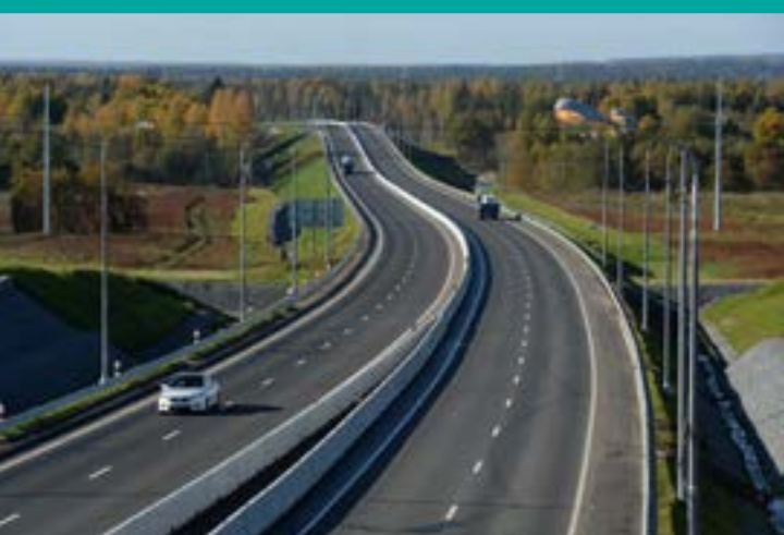
Реконструкция а/д М-11 «Нарва» - от Санкт-Петербурга до границы с Эстонской республикой подъезд к п. Усть – Луга км 16-40
