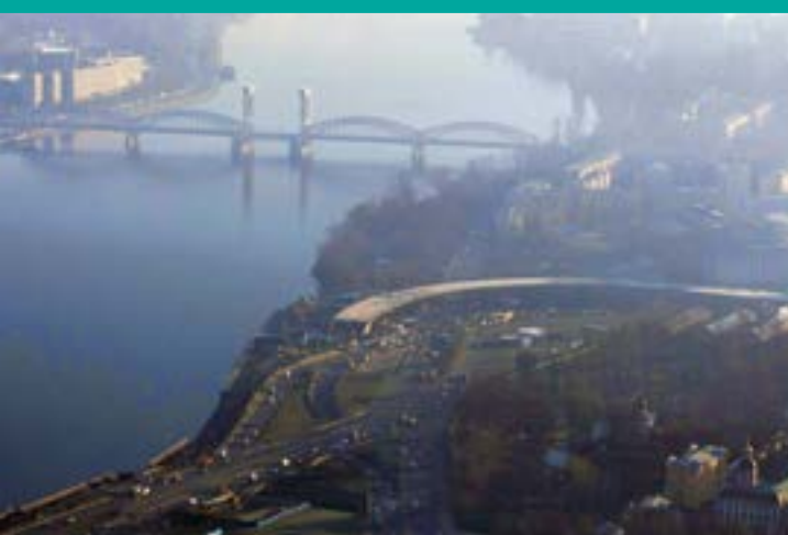
Строительство объекта «Проезда по южному берегу Обводного канала от Глухоозерского шоссе до пр. Обуховской Обороны с мостом через ковш Обводного канала и транспортной развязкой с пр. Обуховской Обороны. 2 этап», Санкт-Петербург
